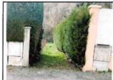
Accès fermé rue Auguste Renoir (n° 58-60)
